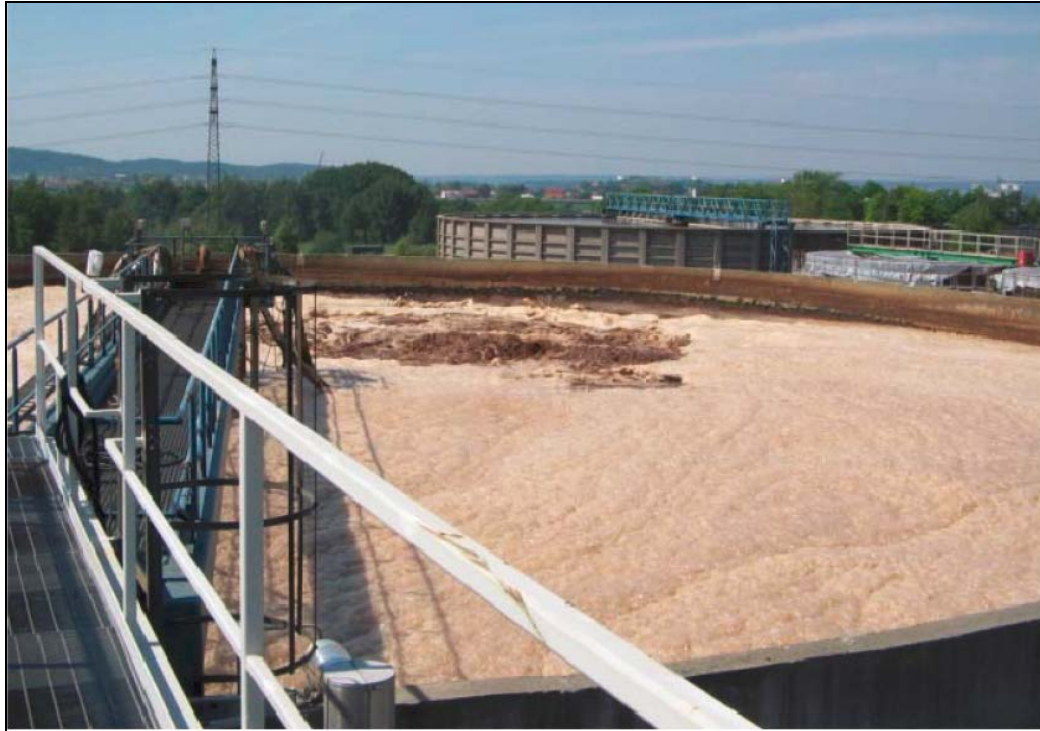
Abb. 34: Belebungsbecken der biologischen Kläranlage des norwegischen Industrieunternehmens Borregaard Ind. Ltd. In unmittelbarer Nähe des Luftwäschers des Unternehmens (Photo: FFI) 60 .
