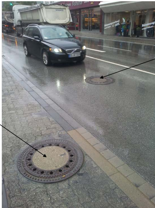
Abb. 49: Verlauf der Abwasserkanalisation der Firma 2 unterhalb des Bürgersteigs und der Mischkanalisation unterhalb Straßenmitte in der Innenstadt von Warstein
