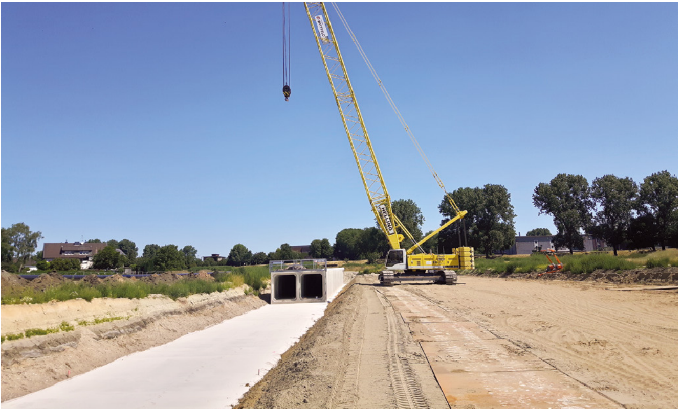
Bau Rahmenprofil
