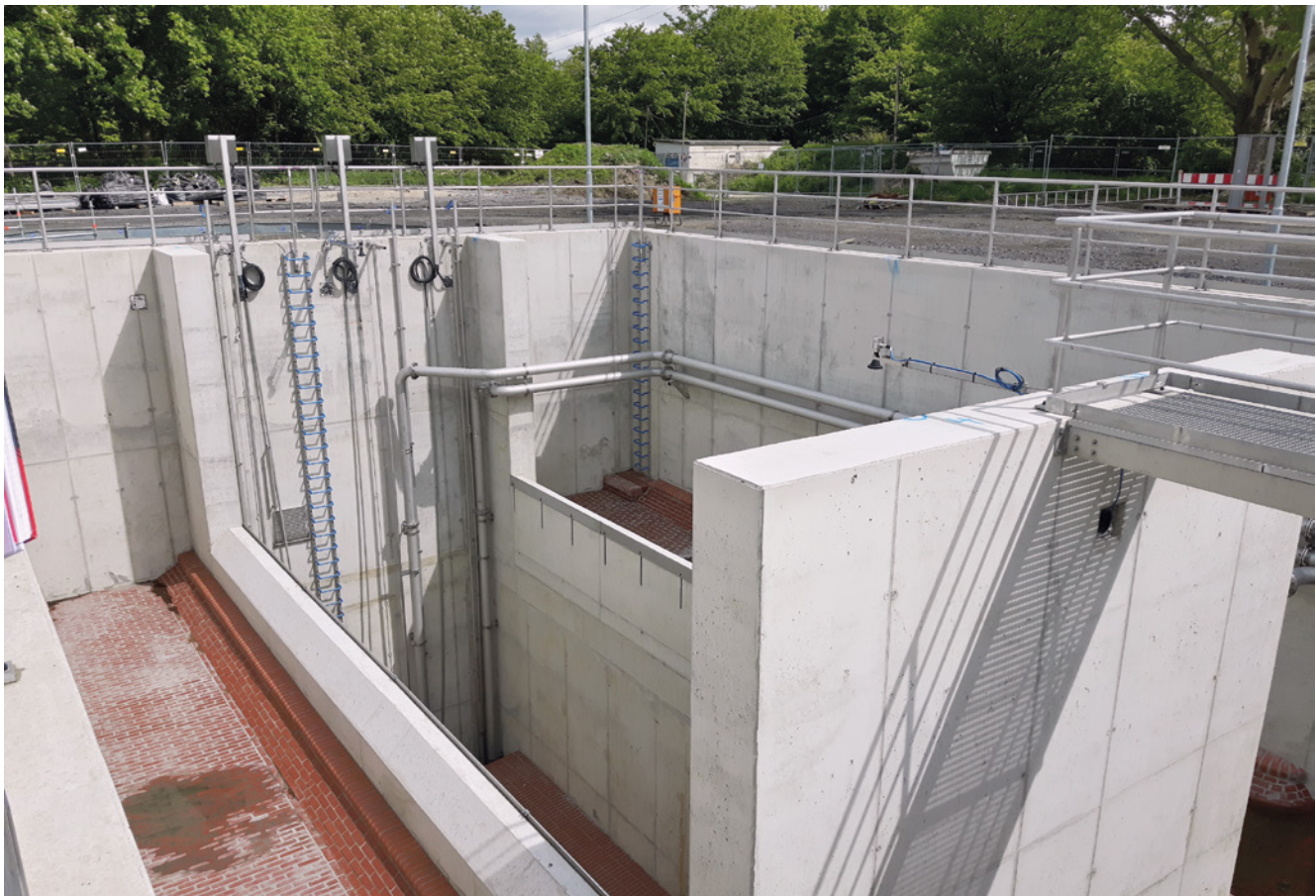
Entlastungsschwelle des Stauraumkanals Essen-Klaumberuch
