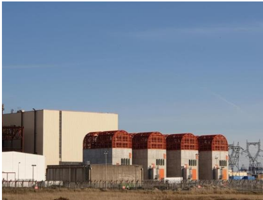
Dieselbetriebene letzte Notstromaggregate (DUS) von 3 MWe
