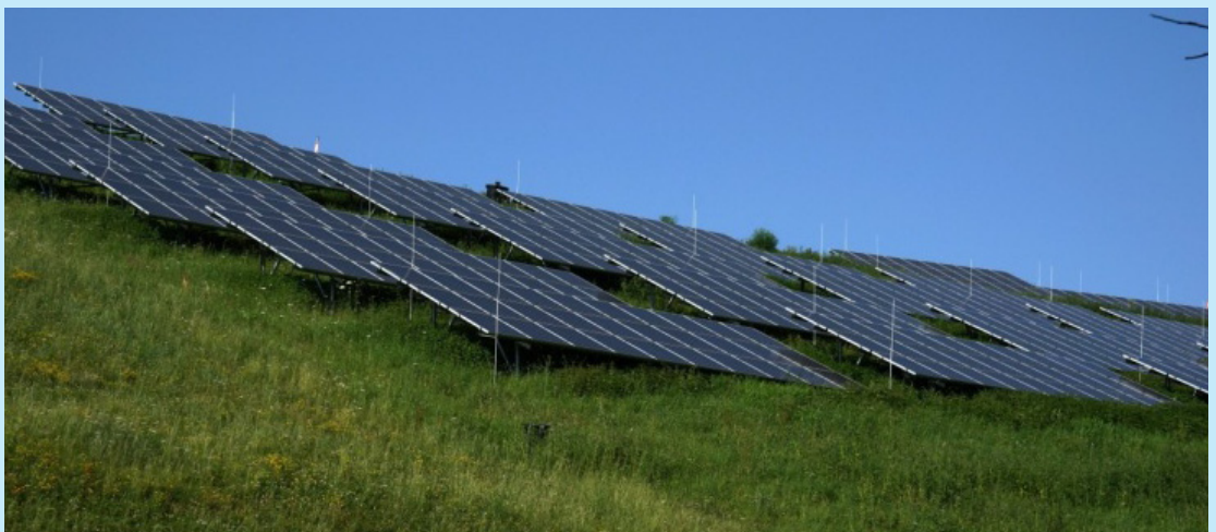
Abb. 13 Modultische mit Blitzableitern Zentraldeponie Münster II
