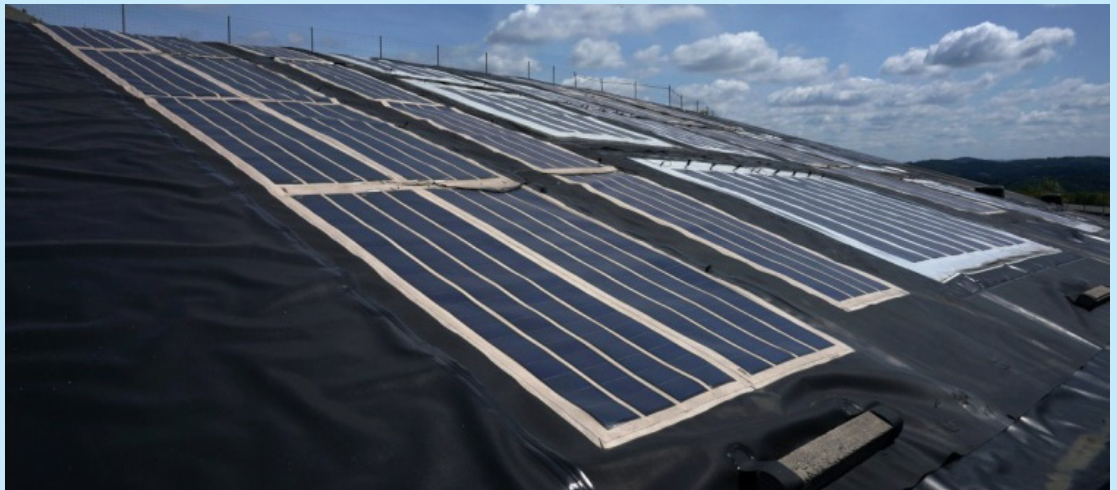
Abb. 10 Aufgeklebte Solarzellen auf einer temporären Kunststoffdichtungsbahn Deponie Leppe (Lindlar)
