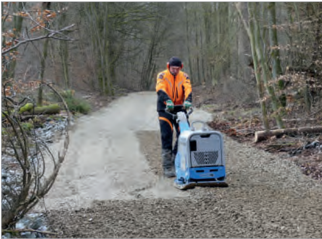
Manche Wanderwege mussten instand gesetzt, bzw. für die weitere Bearbeitung, wie hier im Kermeter für eine Stromleitungsverlegung vorbereitet werden.
