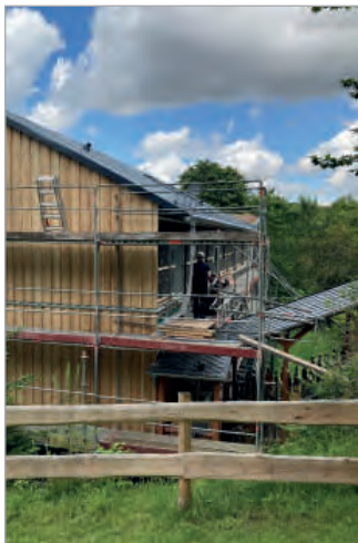
Im Außenbereich des Jugendwaldheims (JWH) wurden für verschiedene Fluchtwege Stahlkonstruktionen im Rahmen des Brandschutzes angebaut.
