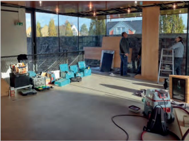
In Nideggen schreiten die Einbauarbeiten im neuen Standort des Nationalpark-Tors am Zülpicher Tor voran.
