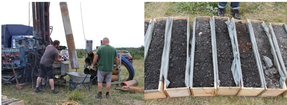
Abbildung 4-2: Bohrung auf MVA-Schlackedeponie Offenbach (l), Bohrkern (r)
