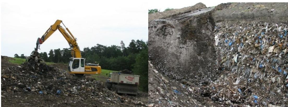
Abbildung 3-3: Materialentnahme Schürfe
